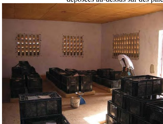
Magasin de 60m 2 avec bassin à eau pouvant contenir 35 tonnes de pdt construit à Dogondoutchi au Niger
