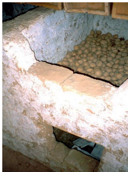
Stockage en silos superposés de +/- 300 à 500 kg/silo, projet VRES, Mali
