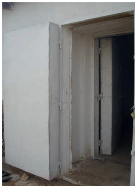
Doubles murs et portes isolées, Bandiagara Mali
